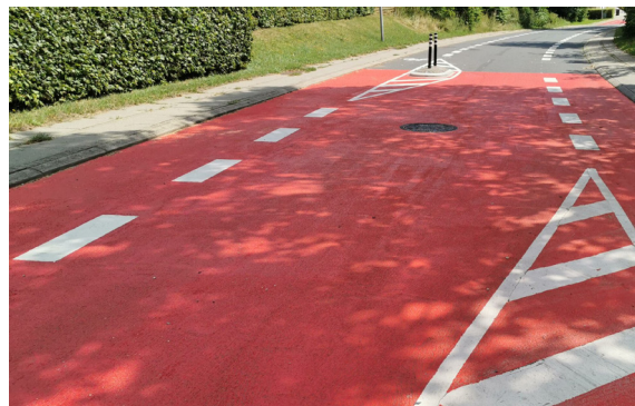
Eksempel belægningsmateriale ved overgange: farvet asfalt
