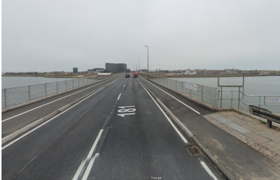
Slusebroen med smalt vejprofil Google street view
